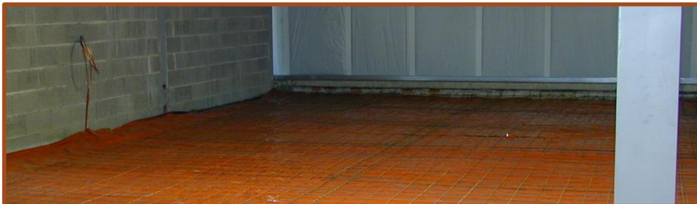
Le TRIDALL®, film de sous-dallage coextrudé bicolore de fabrication française, spécialement développé pour cette application, est issu de la marque POLYANE®, référence dans le bâtiment depuis plus de 50 ans. Convenant parfaitement à un usage professionnel, ce film est destiné à être placé sur le sol avant le coulage de la chape de béton. Sa fabrication tricouche à partir de matériaux nouvelle génération procurera une solidité et une résistance permettant de couler la dalle en toute tranquillité.
